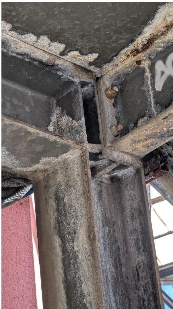
Passerelle Sud : assemblage corrodé
