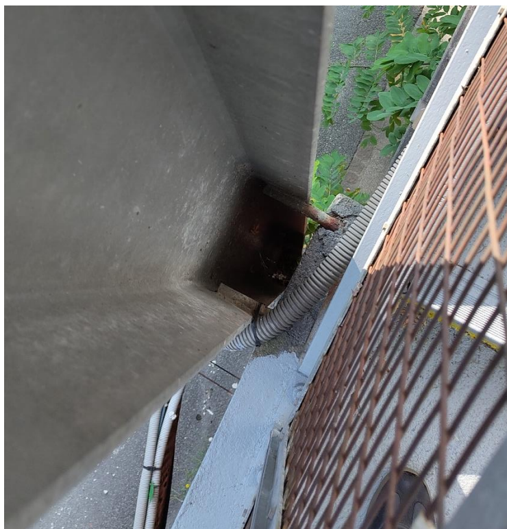
Connexion actuelle par l'intermédiaire d'une barre HA soudée
