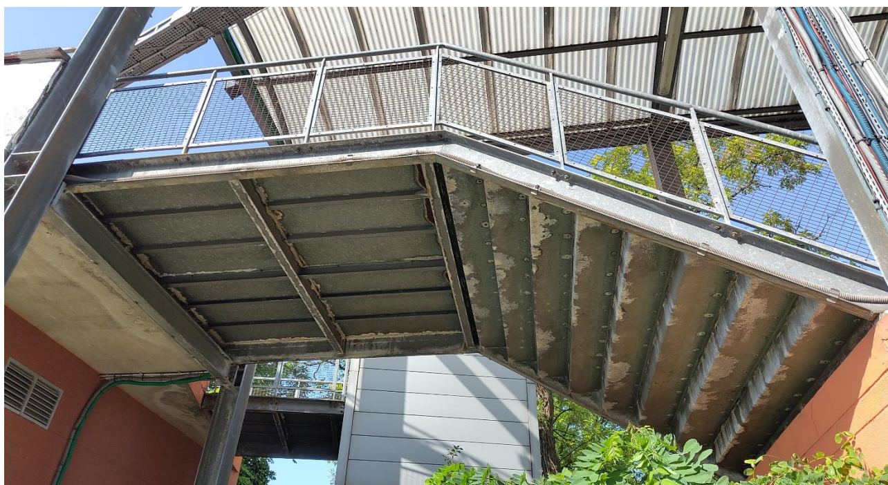
Escalier Nord : Sous-face corrodée
