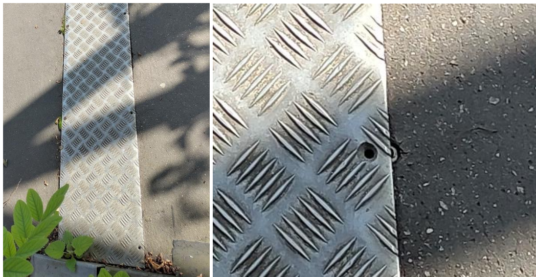
Dilatation non gérée des tabliers visible au niveau de la visserie des tôles larmées à la jonction entre la passerelle Nord et le massif maçonné.
