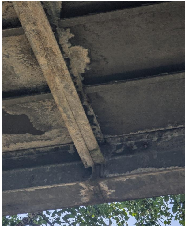
Passerelle Sud : poutre de tablier et tôles corrodées
